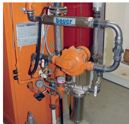
Asennus suoraan linjaan
